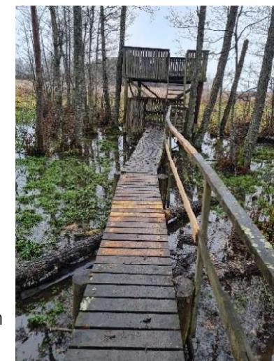
Reparerad spång till Kvarnbäckstornet, december 2025, foto Olle Philipsson
